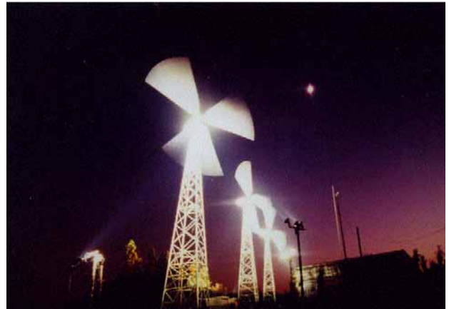
シンボル風車 出力 100kW 3基
